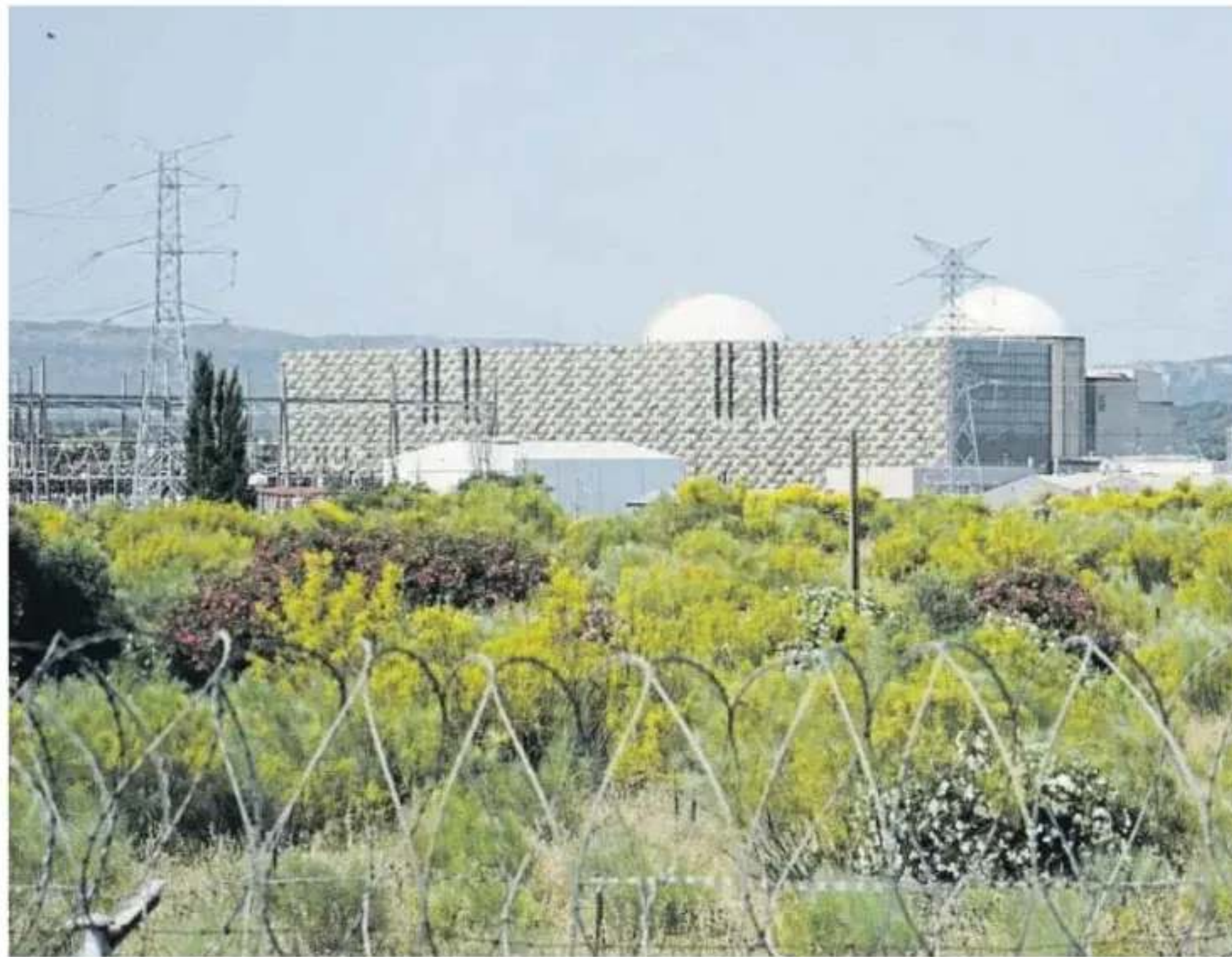
Central Nuclear de Almaraz, en Extremadura
