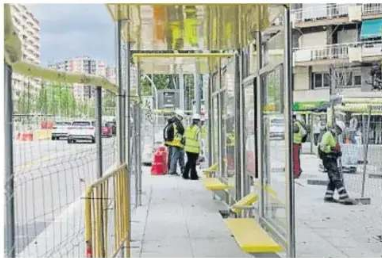
Trabajos de ampliación y mejora de las aceras en la Meridiana
